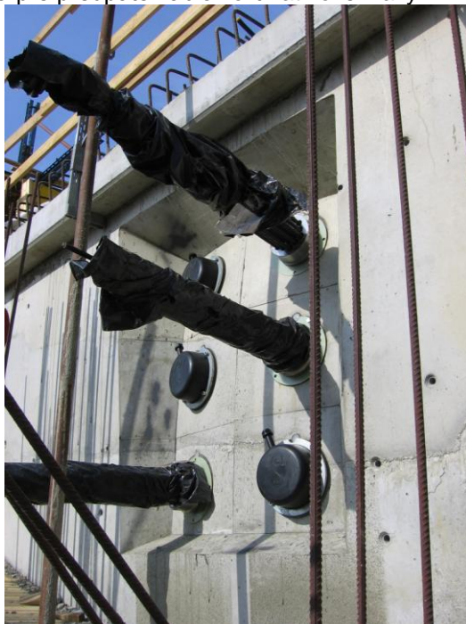
Obr. 15 Príklad elektroizolačného systému uloženia predpätej výstuže, vrátane elektroizolačného uloženia hláv káblov
