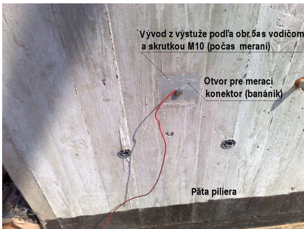
Obr. 7 Príklad riešenia vývodu z výstuže v pilieri pre meranie bludných prúdov
