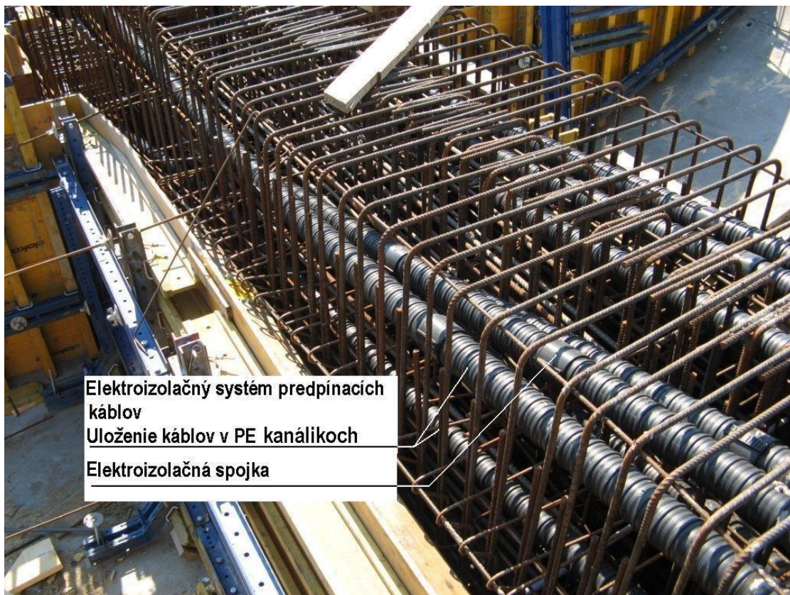
Obr. 13 Príklad elektricky izolovaného predpätia v železobetónovej konštrukcii
